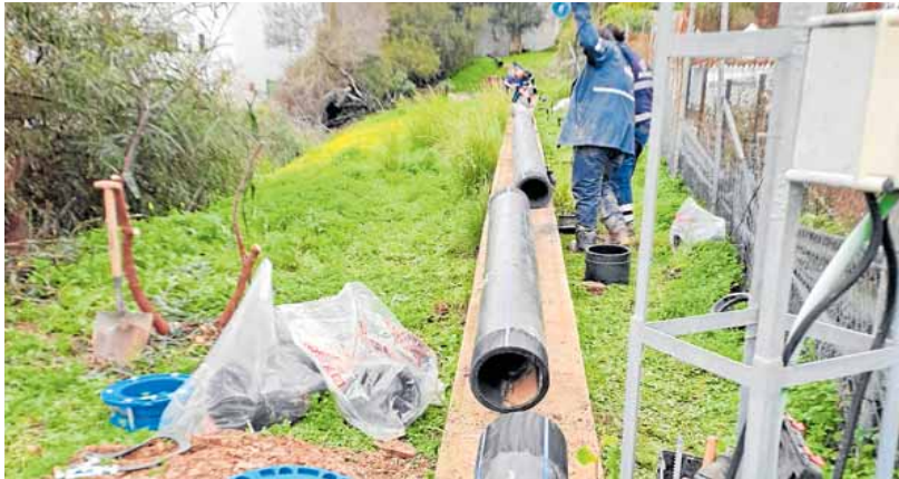
Operarios de Acosol durante los trabajos desarrollados en Mijas Golf para reparar la tubería dañada. sur
