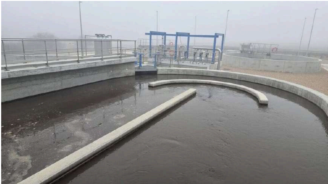
Avances en la depuradora de Torrenueva al aprobar el proyecto
