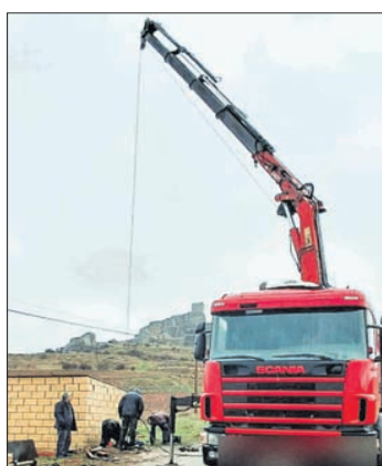
Actuaciones en el pozo.
